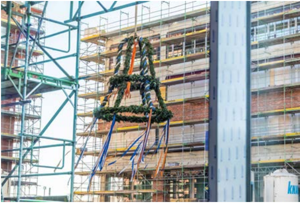
Zum Ende der Veranstaltung wurde der mit bunten Bändern geschmückte Richtkranz von einem Kran in die Höhe gezogen (Bild: HOCHTIEF)
